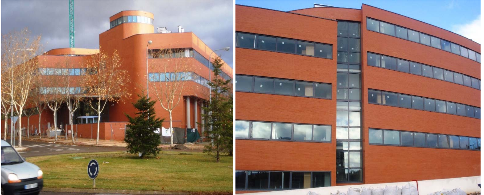
Fachadas del nuevo e imponente edificio, sede de las direcciones provinciales de la TGSS y del INSS en Teruel.
